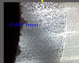
ライニング表 面のフレーキ ング(剥離)
