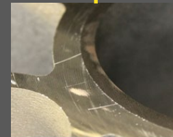
Rayures sur la surface de jointure avec la culasse
